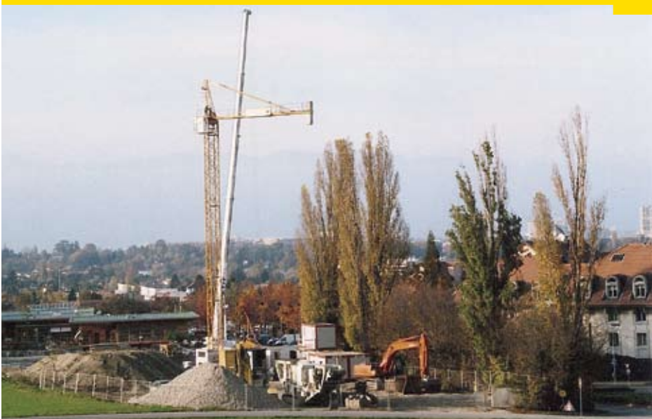
Un EMS de 60 lits se construit sur la parcelle N° 3687.
