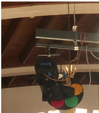
Les lignes d'alimentation graduées des projecteurs existants sont en bon état et seront par conséquent conservées. Il faudra seulement modifier leur départ afin de les adapter à la technologie du LED (gradateurs plus nécessaires).
