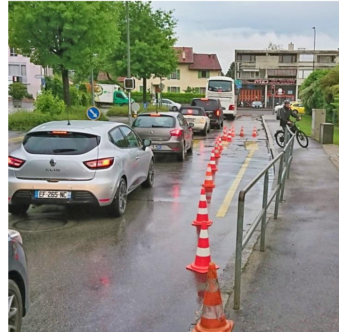
Simulation de la situation projetée : réduction de gabarit au droit du passage piéton et longueur de présélection projetée
