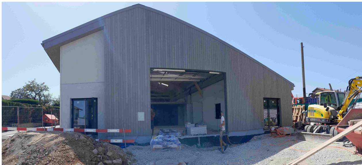
Photo du bâtiment en fin de chantier
