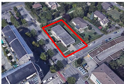
Vue aérienne du bâtiment
