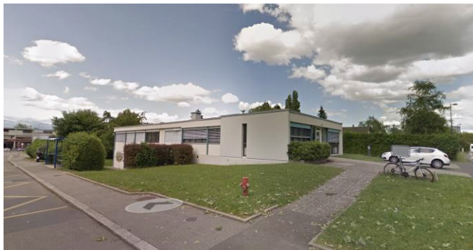
vue du bâtiment depuis les chemins de Vers et des Vuattes
