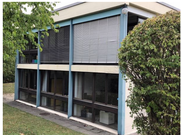
Photographie du pignon (côté promenade) largement ouvert vers l'extérieur
