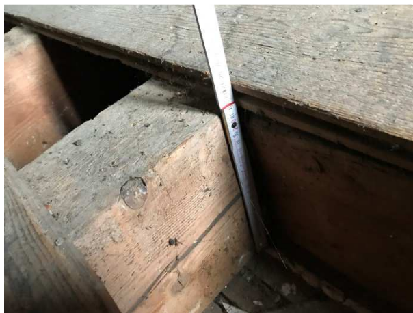
Figure 4 Plancher des combles.
