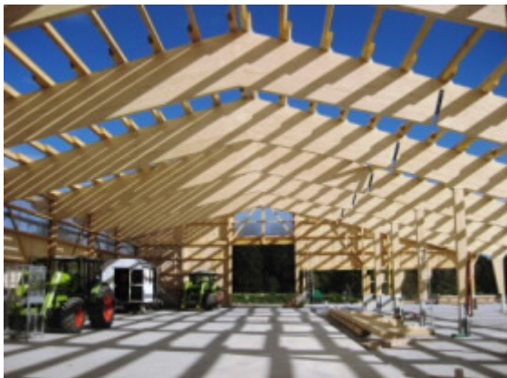
Exemple de halle en portique ossature bois
