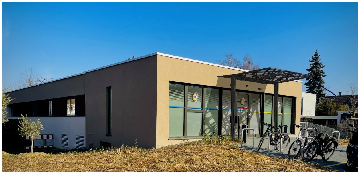
Intégration de l'auvent sur l'entrée de la Police municipale
