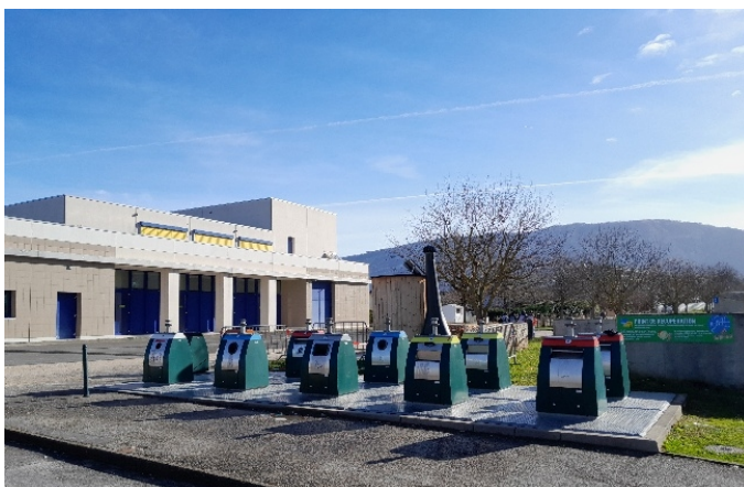
Exemple de containers enterrés sur la commune
