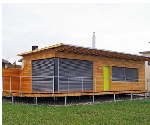
Mise en place de vis « Krinner » et exemple de construction avec ce type de fondation
