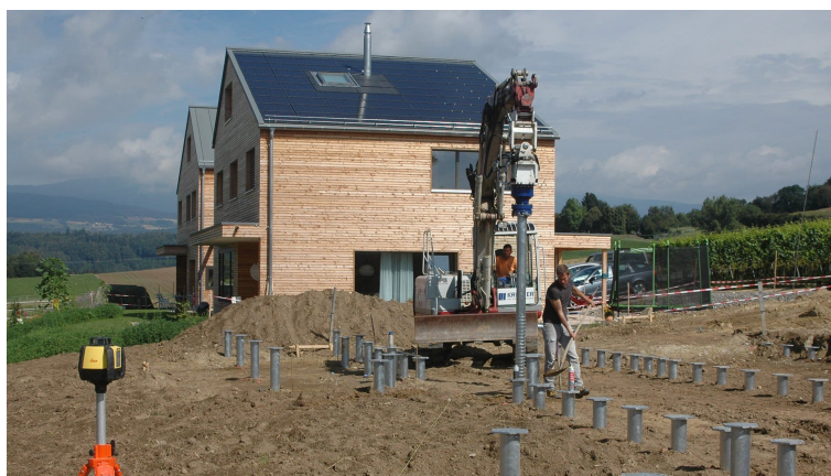
Mise en place de vis « Krinner » et exemple de construction avec ce type de fondation
