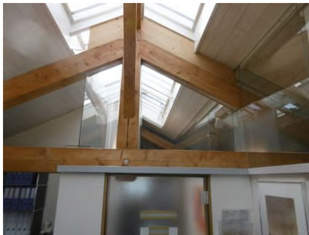
Charpente et verrière de toiture dans les combles
