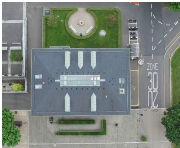
Orthophoto de la toiture de la mairie
